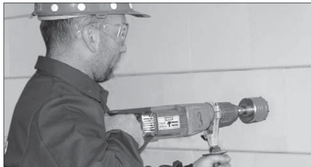
Obr. 25 Vrtání otvoru pro elektroinstalační krabice
