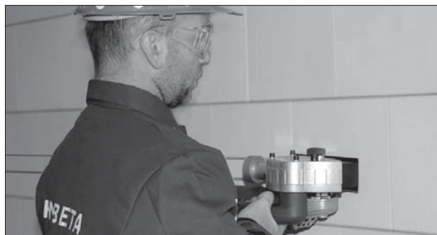
Obr. 24 Řezání vodorovné instalační drážky
