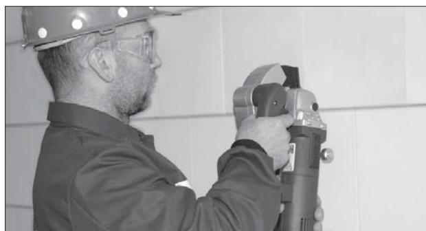
Obr. 23 Řezání svislé instalační drážky
